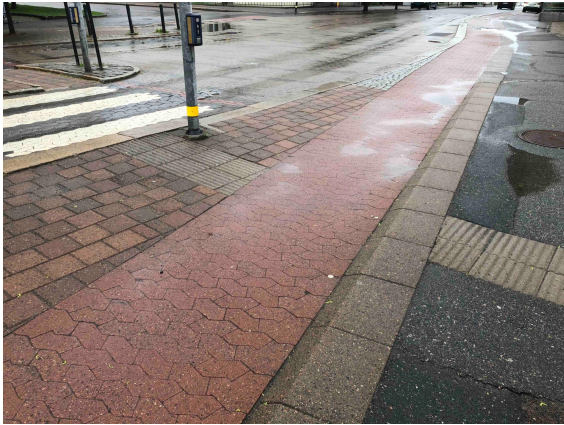
Bild 26. Rullstolar, barnvagnar och cyklister ska kompromissa om utrymme. Nivåskillnad upp mot trottoar. Foto: Jörgen Lundälv
