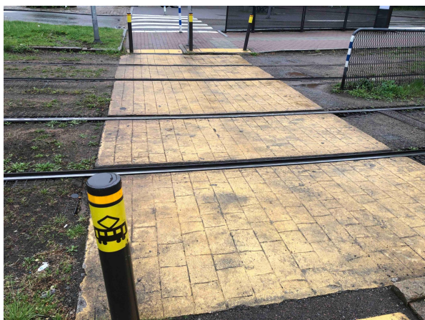
Bild 23. Markeringar för personer med synnedsättningar och spårhinder för rullstolar. Foto: Jörgen Lundälv
