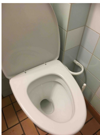
Bild 15. Toalettsitsen måste vara väl förankrad
