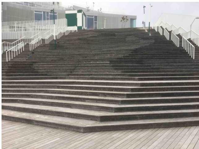
Bild 26. En nybyggd bred trätrappa i Köpenhamn år 2017.
